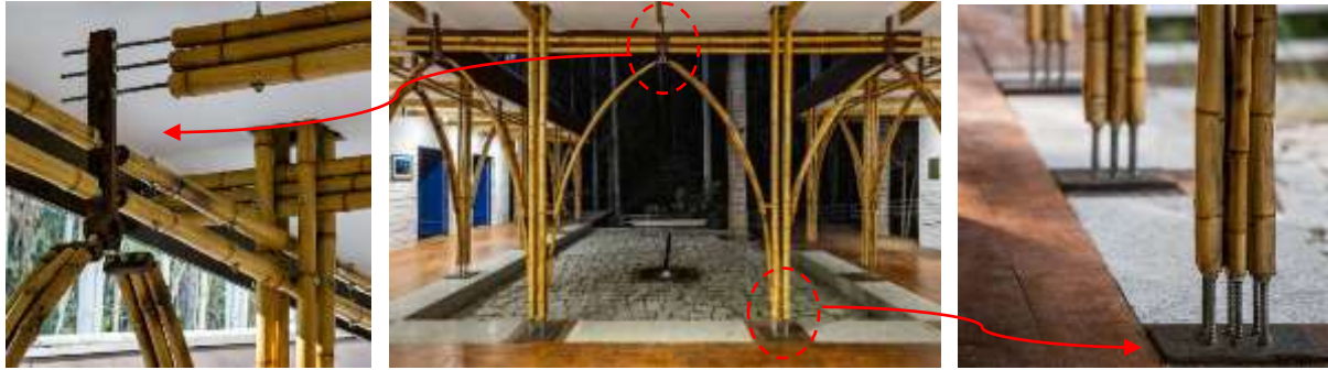
شكل رقم ( ١٣ ) يوضح التفاصيل التنفيذية لتركيب الجزء السفلي (الاعمدة ) و الجزء العلوي لهيكل البامبو. (Abdel, 2022)
