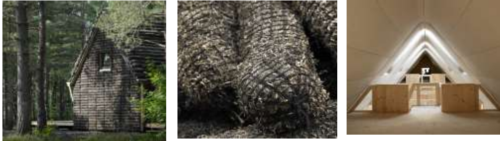
شكل رقم ( ١٤ ) يوضح تصميم منازل بالدنمارك الأسقف و الحوائط الخارجية من الأعشاب البحرية https://www.dezeen.com/2013/07/10/the-modern-seaweed-house-by-vandkunst-en-realdania/
