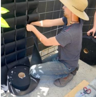
شكل (26) الجيوب و هي عبارة عن نسيج يتم تثبيته في هيكل النظام
