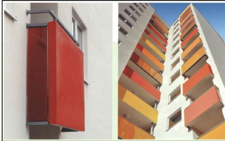
شكل (17) مجمع سكني Streksbarg بمدينة هامبروج الألمانية معالج بدهانات معالجة نانوية بمادة ثاني أكسيد التيتانيوم تكسبها خاصية التنظيف الذاتي والحماية من الرطوبة والأملاح لوقوعها في منطقة ساحلية
