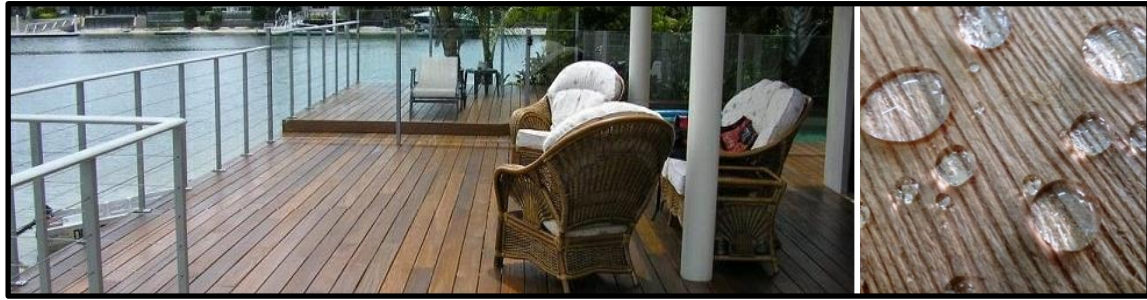
شكل (24) أرضيات خشبية معالجة بطلاءات من بمواد نانوية شفافة
