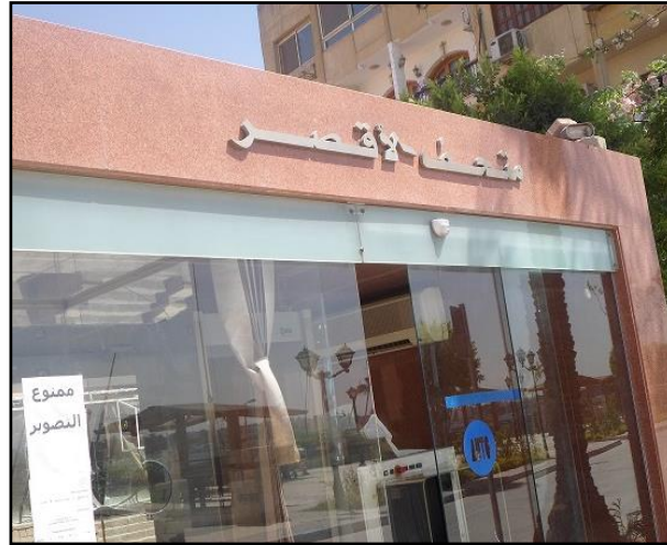
شكل (46) استخدام الجرانيت غير المعالج في تغطية المدخل ، والزجاج في المدخل الرئيسي غير معالج وتظهر به الانعكاسات ، وعدم الحماية من الأشعة فوق البنفسجية والأشعة تحت الحمراء
