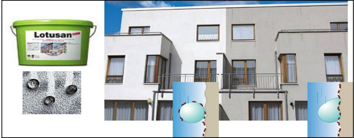
شكل (16) نموذج لمبنى استخدم في دهان واجهاته طلاء معالج بتقنية النانو لإكسابه خاصية التنظيف الذاتي self-cleaning بتأثير اللوتس http://exposicio.cdmt.es/tecnologia-lotus-effect.html
