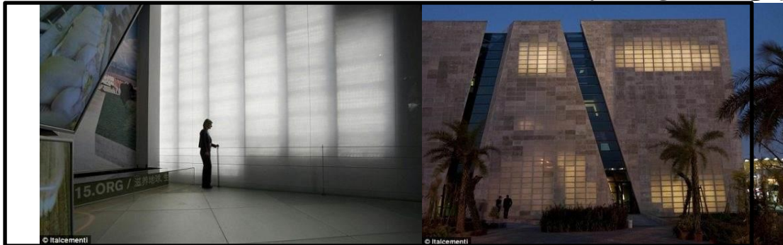
شكل (5) الجناح العالمي من الخارج والداخل بمعرض إكسبو 2010 بالصين ، تم تصميم وتنفيذ واجهته بالخرسانة الشفافة التي تحقق رؤية من خلالها وتضفي بساطة ولمسة جمالية على المبنى ، كما أنها صديقة للبيئة .
