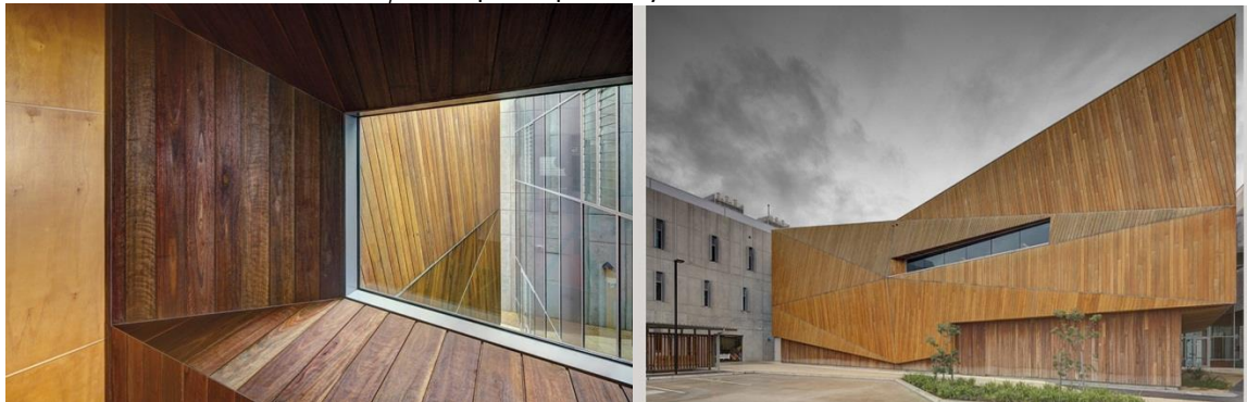
شكل (29) استخدام المركبات الخشبية المصنعة بالنانوتكنولوجي في توكسيات الحوائط والأسقف وداخل الحيزات الداخلية بمعمل النانوتكنولوجي EMC بجامعة وولونجونج Wollongong في أستراليا
